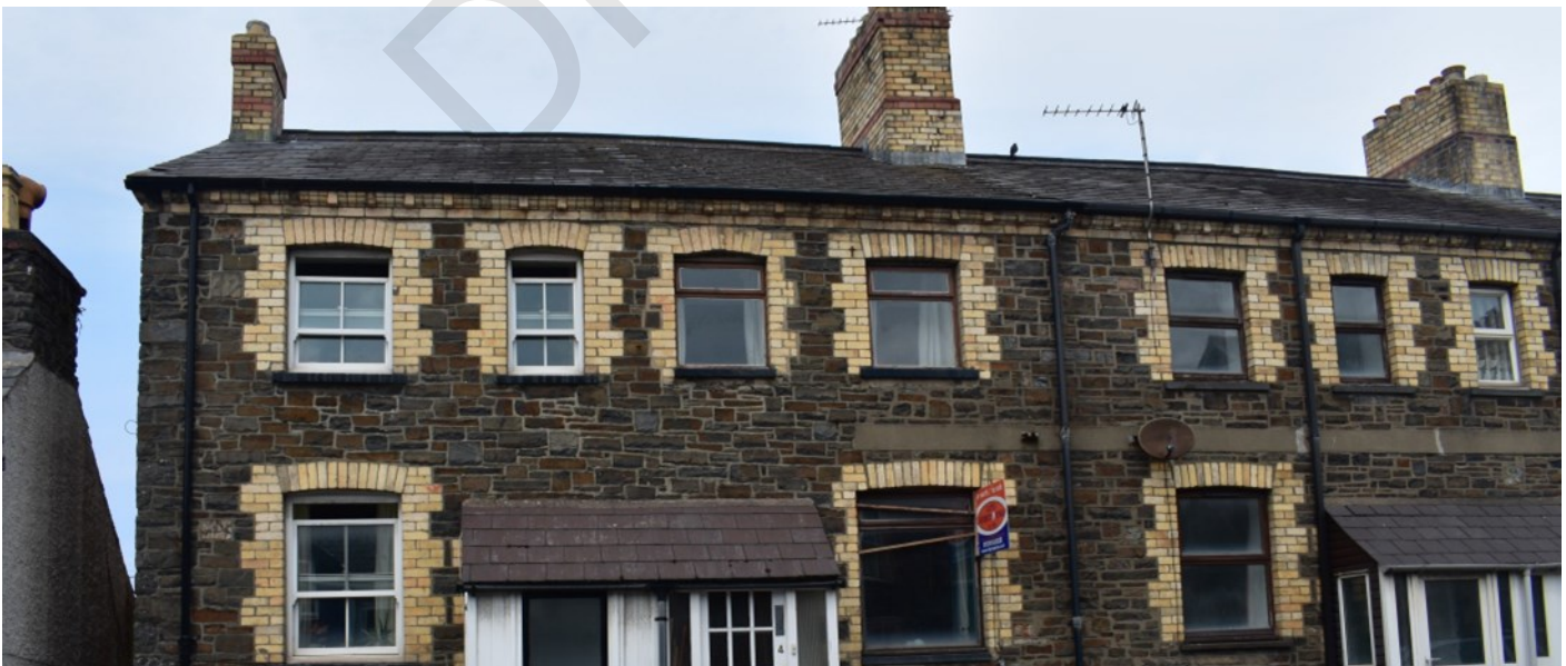
Ffigur 25 Mae manylion brics cyferbyniol o amgylch ffenestri a drysau a simneiau yn ychwanegu nodweddion unigryw at resi o derasau gwahanol
